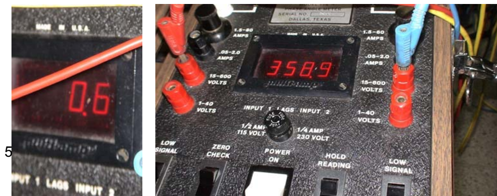
Fig. 4.35 Foto del medidor de fase utilizado para medir la corrección del desfase del DVR: Corrección de fase a 0.425 (Izquierda) y a 0.0015 (derecha).
