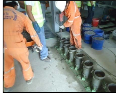
Figura 8 Proceso de compactación del HCR.
