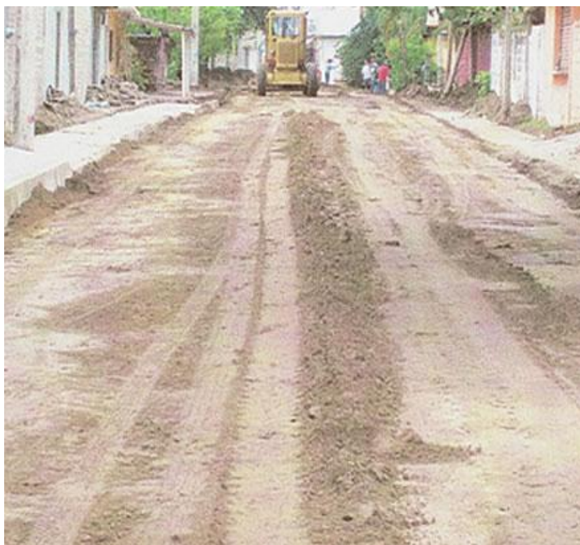
Figura 2.5 Sub-rasante en via
