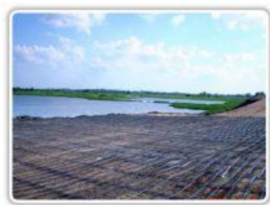
Figura 1.8 Terreno reforzado con Geored
