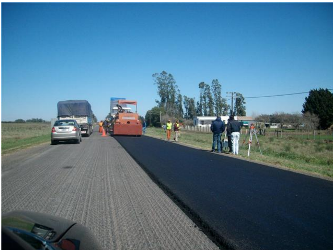
Figura 2.3 Pavimentación de carril de autopista
