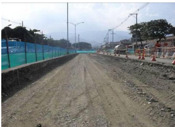
b) Refuerzo de Sub-rasante
