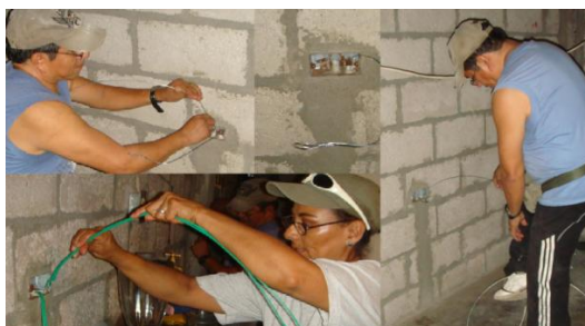
Figura 108. Instalación de cable a través de tubo PVC.
