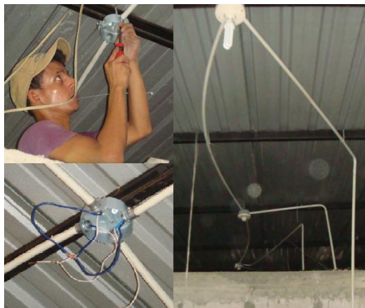
Figura 109. Instalación de tubo PVC y cables.
