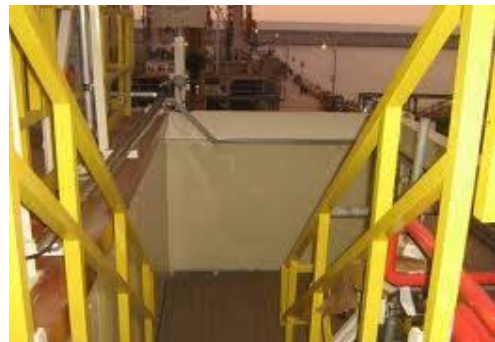
Baranda de escaleras
