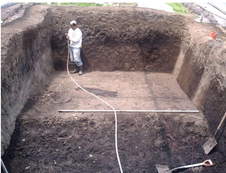
Figura 16: Construcción del tanque.
