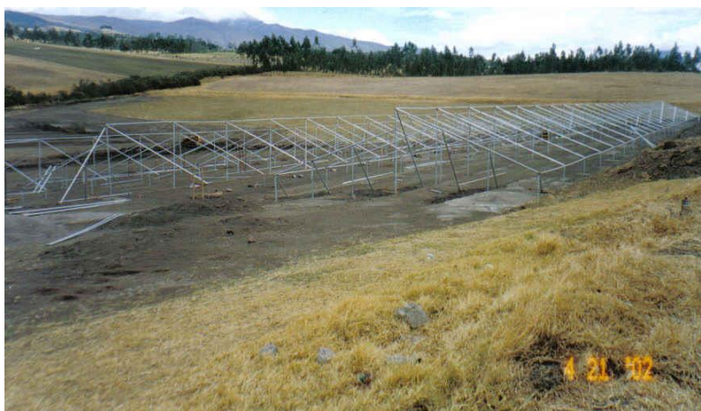
Figura 14: Construcción de la estructura de los invernaderos.
