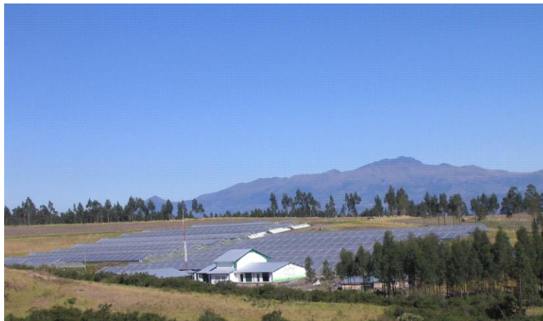
Figura 12: Planta de Mertens & Asoc. S.A.
