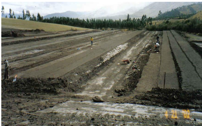
Figura 13: Vista de las rampas conformadas en el terreno.
