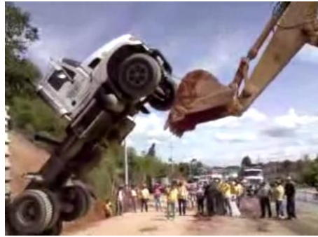
Figura 56. Problema presentado en obra con la Volqueta (a). (Fuente: Publicaciones del Departamento de Ingeniería de la Construcción de la Universidad de La Laguna).
