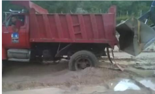
Figura 56. Problema presentado en obra con la Volqueta (b). (Fuente: Publicaciones del Departamento de Ingeniería de la Construcción de la Universidad de La Laguna).
