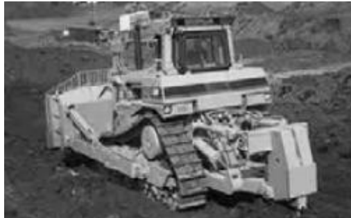
Figura 42. Tractor trabajando en un movimiento de tierra. (Fuente: Publicaciones del Departamento de Ingeniería de la Construcción de la Universidad de La Laguna).
