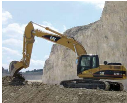
Figura 58. Excavadora en corte.
