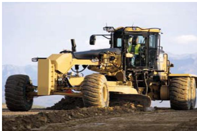
Figura 54. Motoniveladora tendiendo material (FUENTE: Manual de maquinaria Caterpillar para movimiento de tierras, O. P. y Minería).
