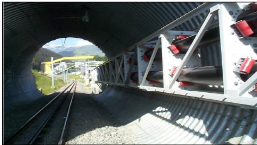
FIGURA 2.7 INSTALACIÓN TÚNEL GOTTHARD SEDRUM SUIZA [13]
