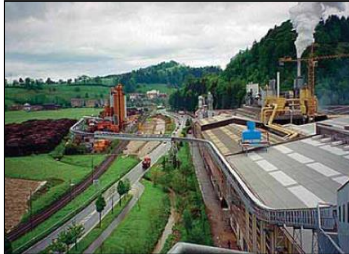
FIGURA 2.1 INSTALACIÓN KRONOSPAN INC. SUIZA [5]
