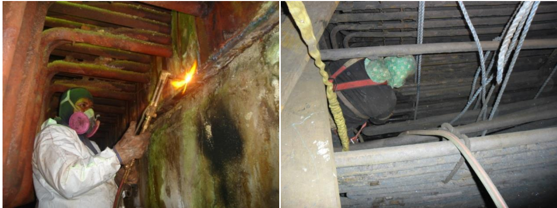
FIGURA 5.8 CORTE DE TUBERÍA CON PROCESO OXIACETILÉNICO.
