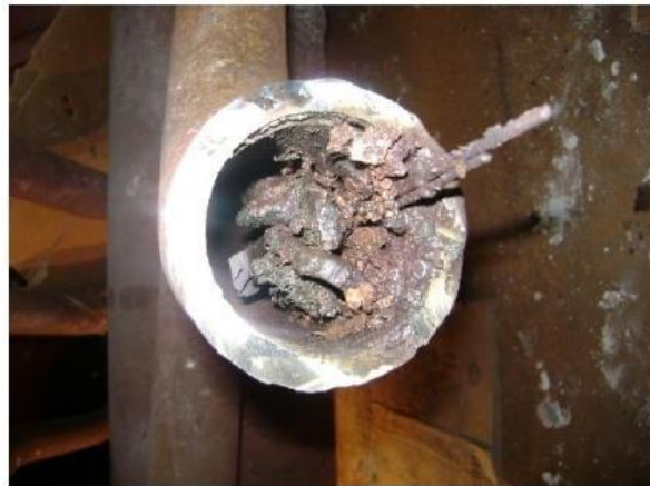
FIGURA 2.16 MECANISMO FALLA POR CONTROL DE CALIDAD.
