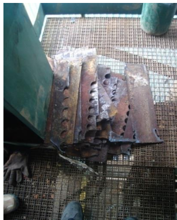
FIGURA 5.7 PLACAS Y PEINES RETIRADOS DE LA CÁMARA
