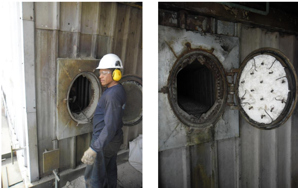
FIGURA 5.4 DEMOLICIÓN Y REPARACIÓN DE REFRACTARIO EN MANHOLE DE INGRESO AL CALDERO.
