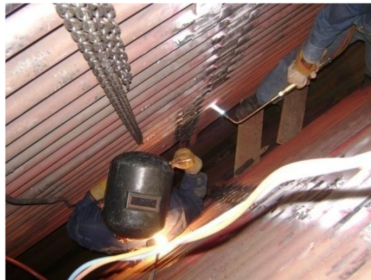
FIGURA 5.18. PRECALENTAMIENTO DE ELEMENTOS.
