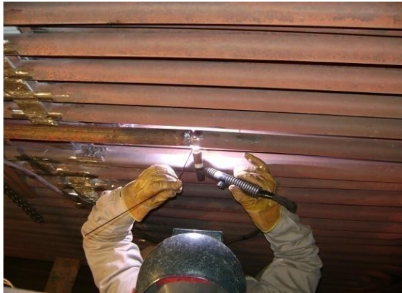
FIGURA 5.19. APLICACIÓN PASO DE RAÍZ EN SOLDADURA.
