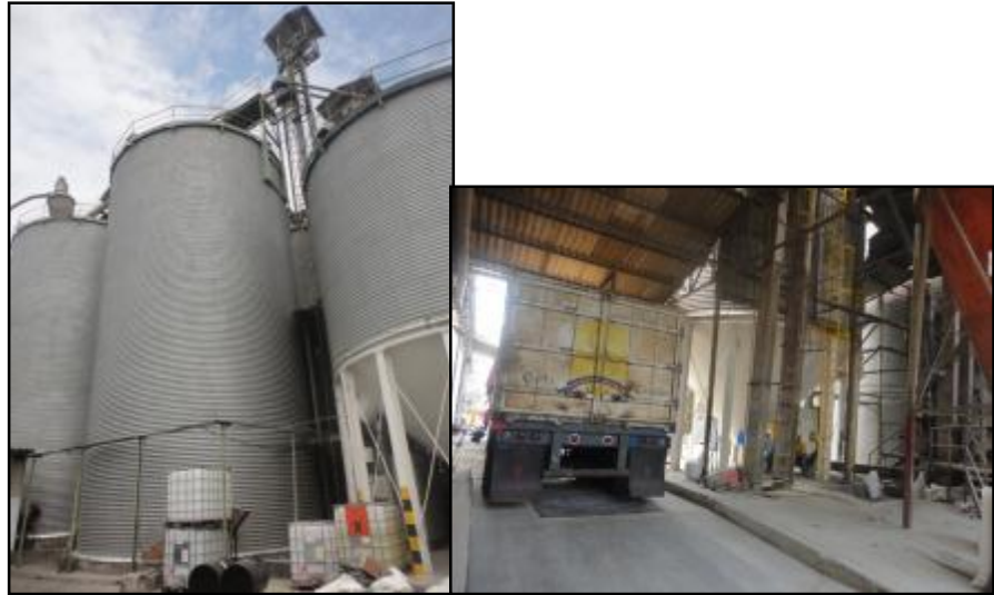
Figura 3.3 Área de Silos
