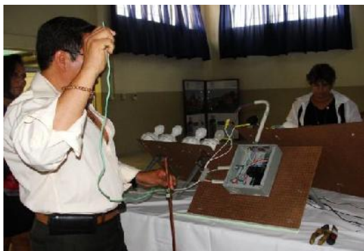
Foto 3: Instalación de un panel de breaker
