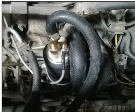
Figura 3.22 Instalación de bomba de combustible. Fuente: Autor: - Gabriel Webster
