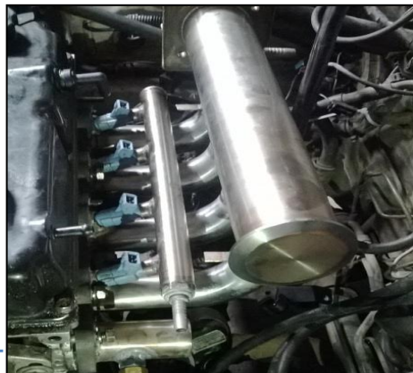
Figura 3.18 Instalación de múltiple de admisión nuevo.
