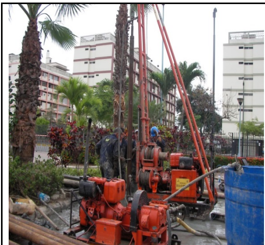
Foto de Perforación en P4
