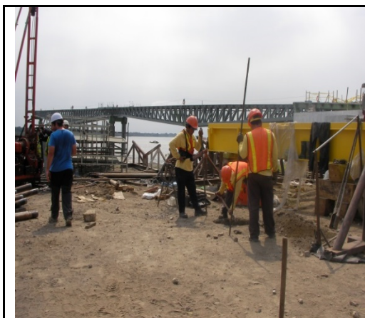
Foto de Perforación en P5
