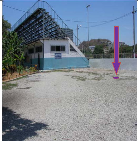
Vista Panorámica de la Perforación 2. Fuente: INER.
