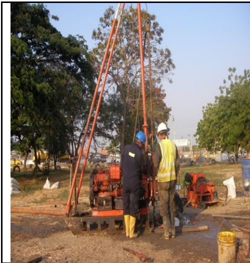
Foto de Perforación en P10
