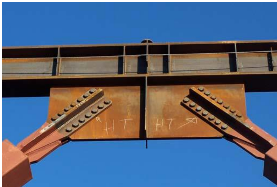
Figura 2.27. Conexión emperrada modificada de un APR (Hussain, et al., 2006)
