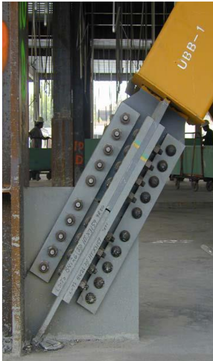
Figura 2.26. Conexión emperrada estándar de un APR (Hussain, et al., 2006)
