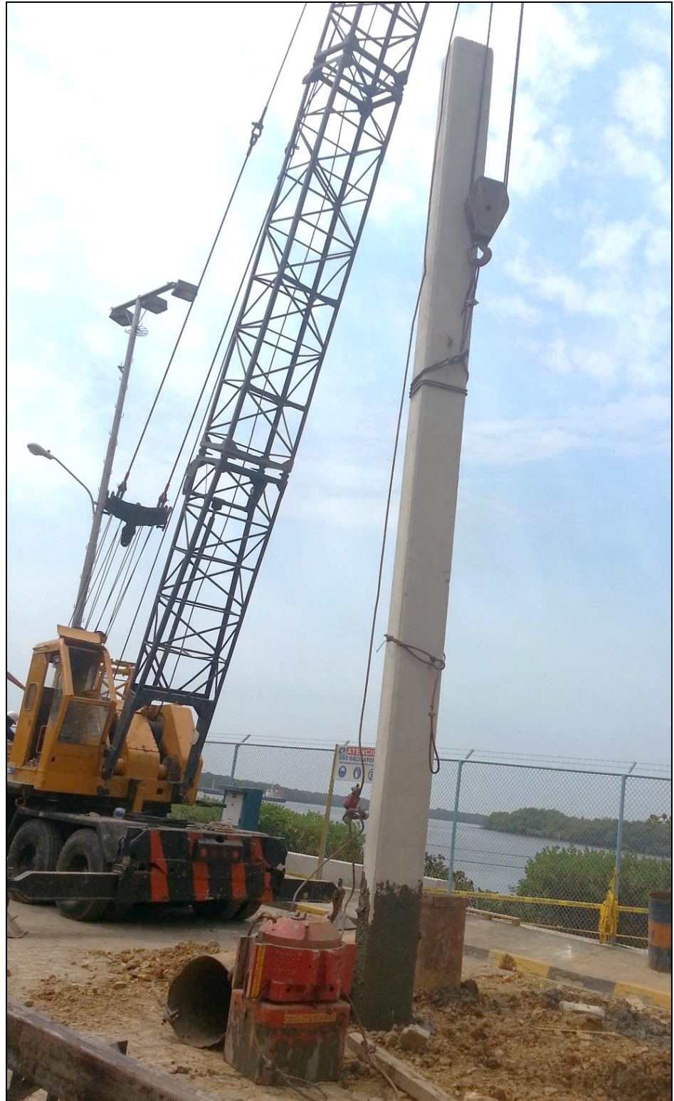
Figura 5.21. Colocación del pilote.
