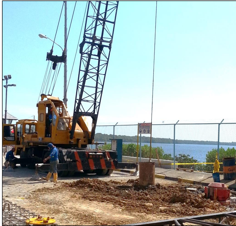
Figura 5.17. Colocación de la camisa recuperable.
