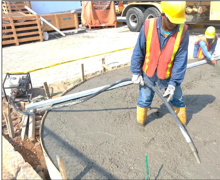
Figura 5.27. Vibrado de las partículas de concreto durante el vaciado.
