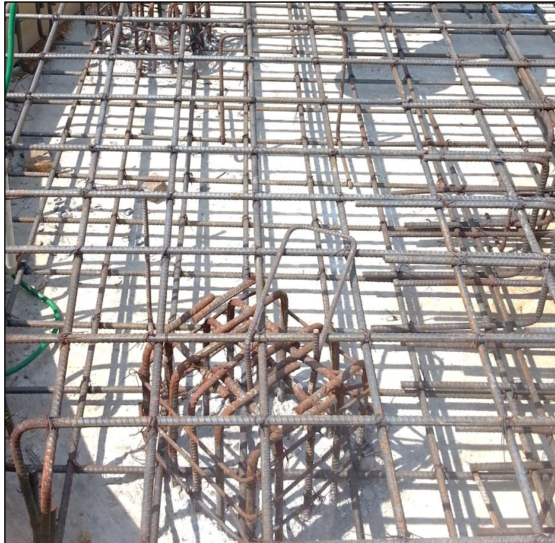
Figura 5.24. Figurado de hierro.
