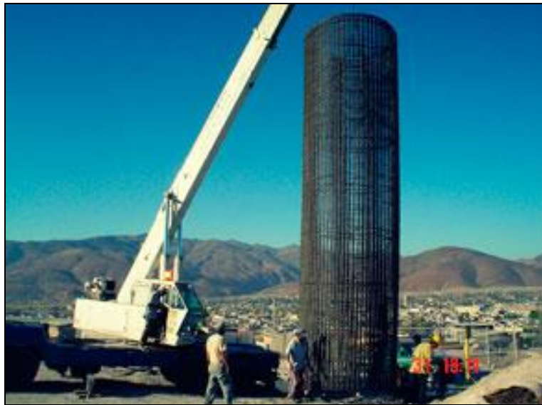
Figura 2.5. Pilas.
