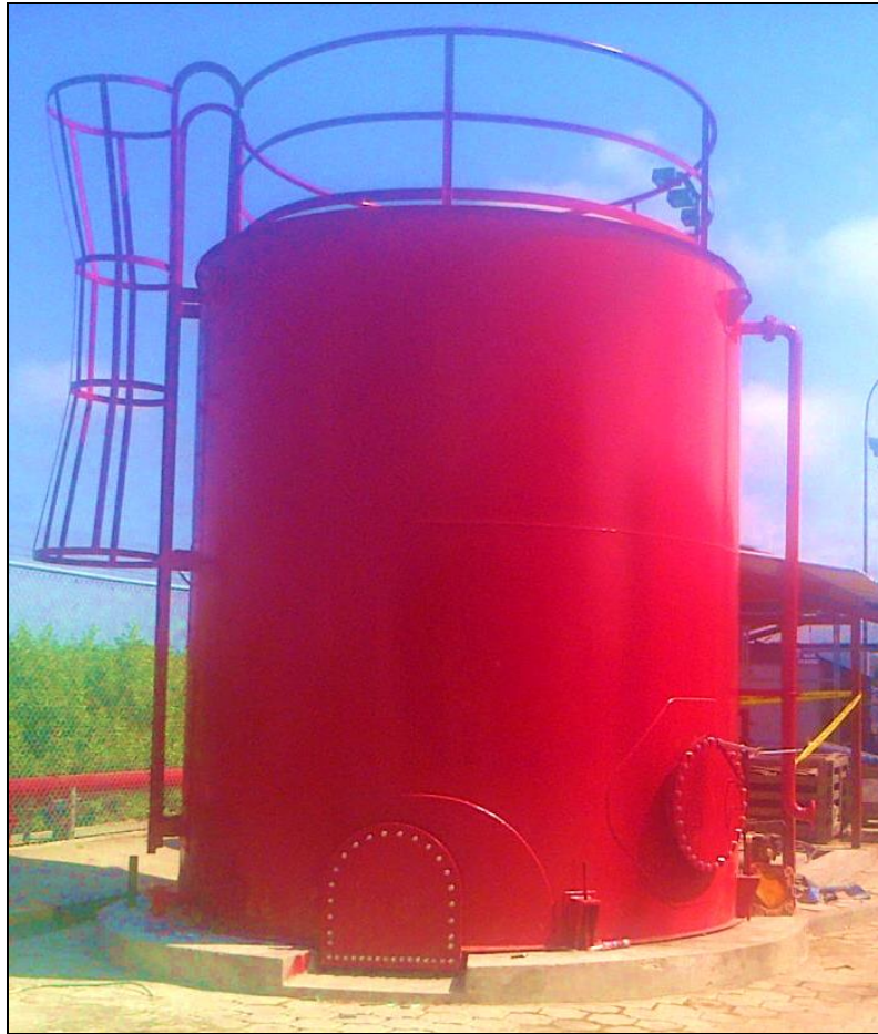
Figura 5.29. Tanque de 12000 galones sobre la cimentación construida.
