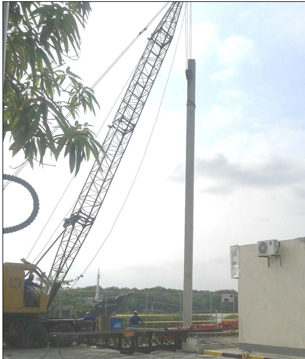
Figura 5.20. Izado del pilote.
