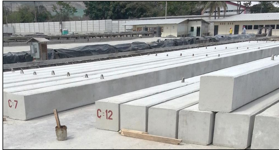
Figura 5.15. Pilotes prefabricados por la empresa Ditelme.
