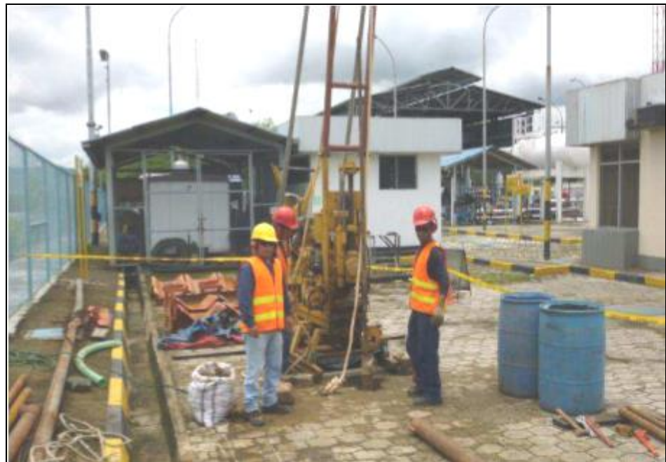
Figura 3.2. Equipos de perforación.
