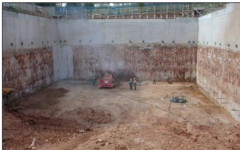
Figura 2.4. Muros Pantalla.
