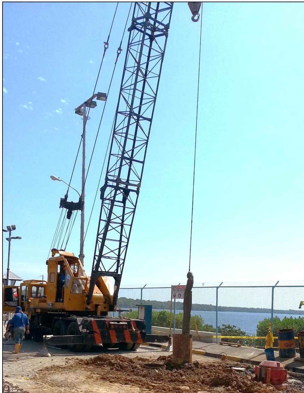
Figura 5.19. Perforación del agujero del pilote.
