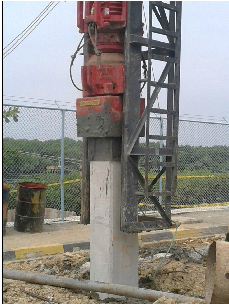
Figura 5.23. Martillo a diésel para hincado de pilotes.
