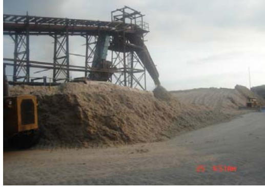
Figura 2.7 Patio de almacenamiento de bagazo
