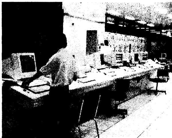
Figura 1.3. Sala de control.
