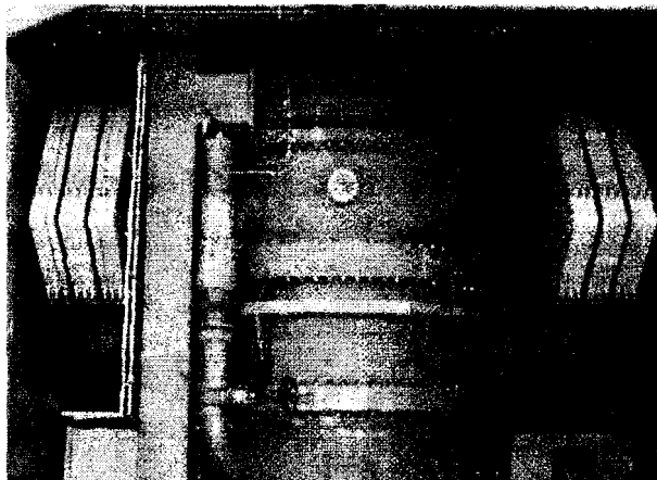
Figura 4.7. Válvula mariposa en operación.
