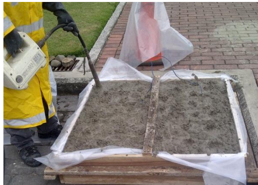
Gráfica 5.7: Compactación de la Losa por Vibración
