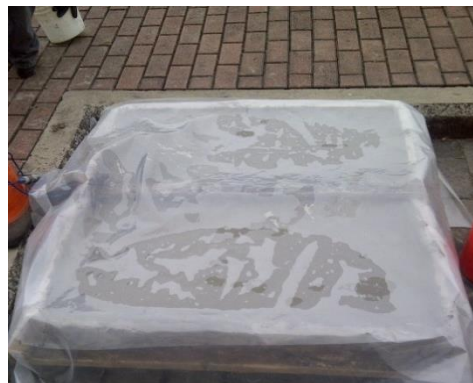
Gráfica 5.9: Losa protegida de la pérdida de humedad
