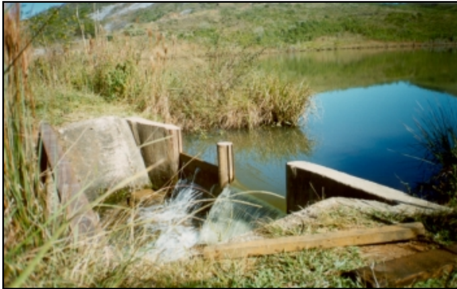
FOTOGRAFIA A1 RESERVORIO DE CAPTACION "CAPAO"
