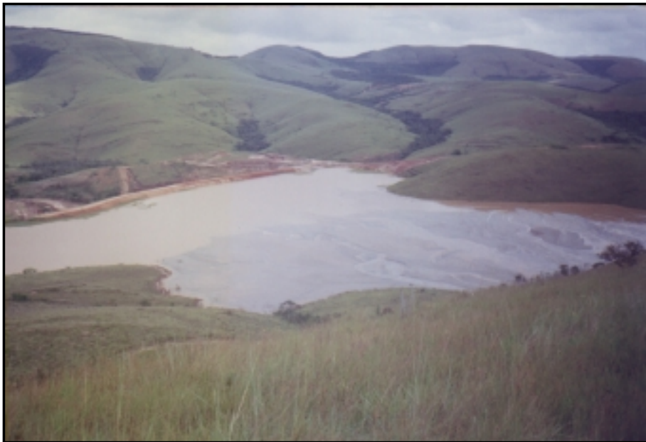
FOTOGRAFIA A7 RESERVORIO DE RESIDUOS SÓLIDOS
