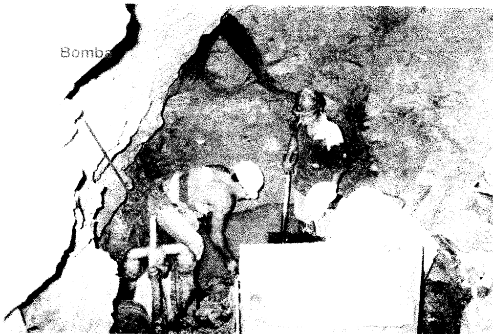
Foto 4.4. Bomba de succión en el pozo 3 (P3)
