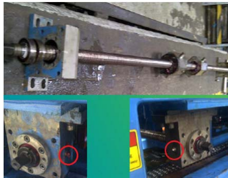
Fig. 4.3 Cambio de Rodamientos (Cierre y Apertura de Moldes Formadores)
