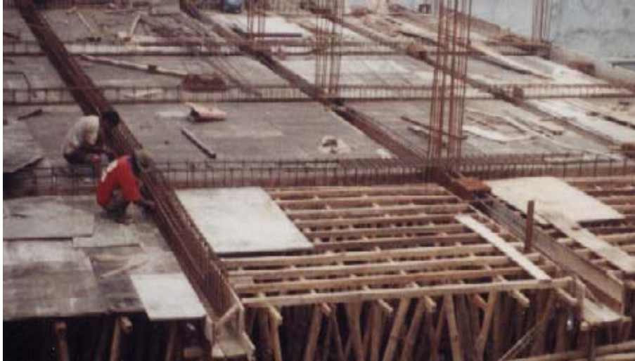
FIGURA 2.5. ELABORACIÓN DE ENCOFRADOS EN UNA CONSTRUCCIÓN
