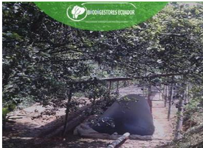
Figura 1 Modelo de Biodigestor tubular de geo membrana PVC
