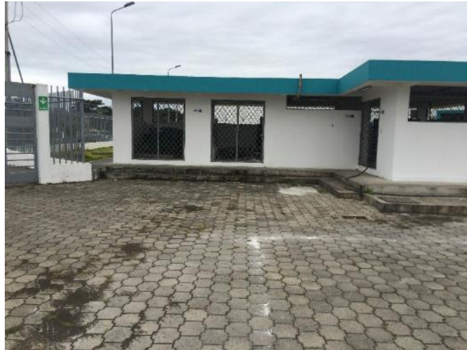
Figura 3.3. Casa de Maquinas Fuente. Tomada por el autor
