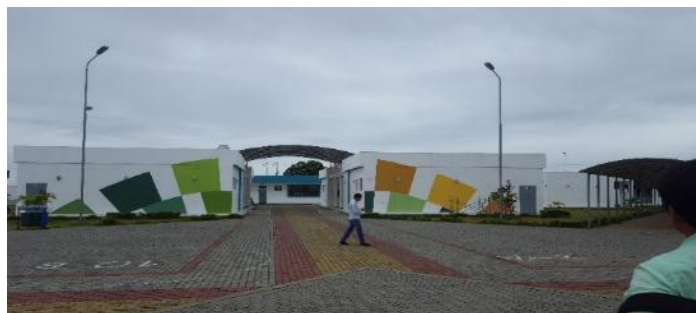
Figura 3.2. Bloque de Administración Fuente. Tomada por el autor
