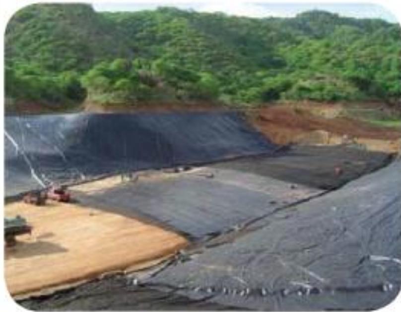
Figura 3.9: Geotextil aplicado en un relleno sanitario Fuente: PAVCO
