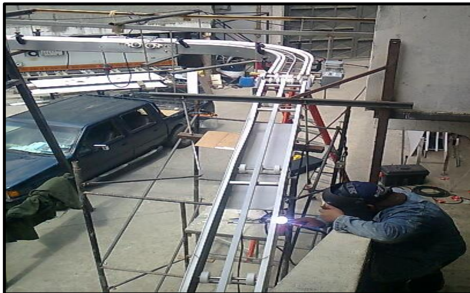
Figura 2.20 Proceso de Construcción de los Transportadores
