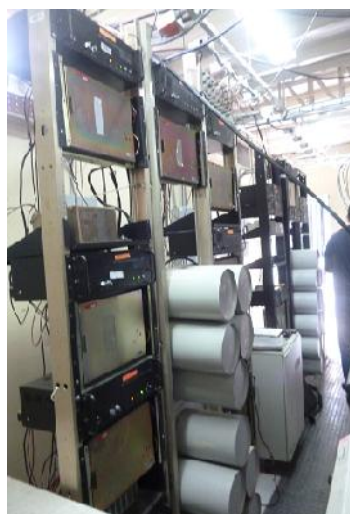
Figura A.4: Equipos troncalizados utilizados a través de la radio base Cerro Azul
