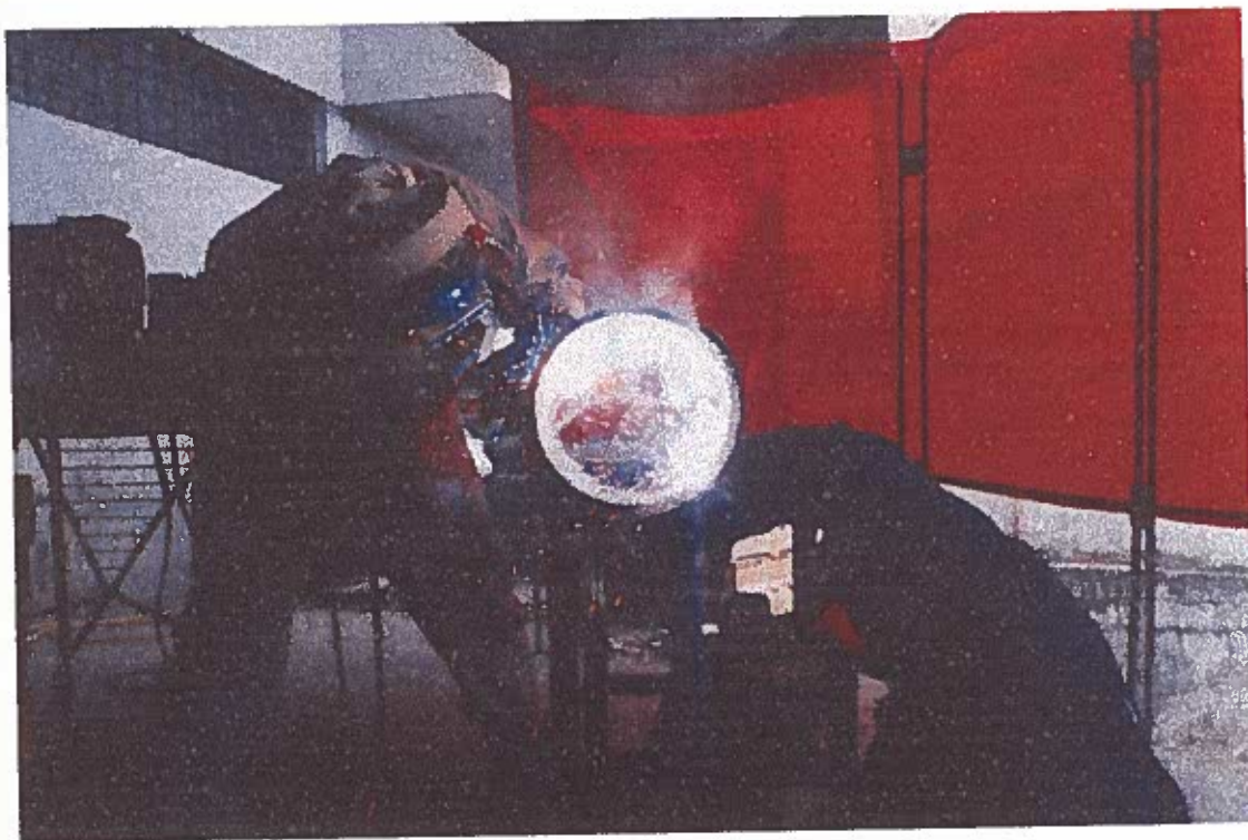
Fig. 12 Realizando soldadura en tubería con proceso SMAW.
