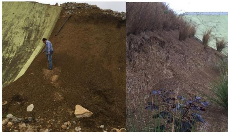
**Figura 3.8.** Fotografía del talud a un costado del muro de hormigón con presencia de material suelto producto de deslizamientos.
