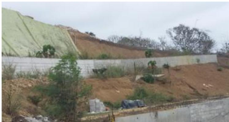
**Figura 2.11.** Vista del sitio de obra donde se observa lutitas y limolitas bien laminadas y fracturadas que pertenecen al miembro Villingota.
