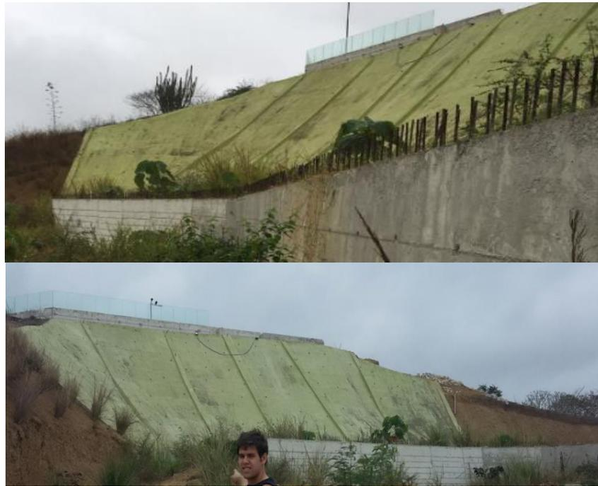
**Figura 3.4.** Muro de hormigón, construido en el talud más pronunciado de la ladera, justo detrás de donde se plantea construir la edificación.
