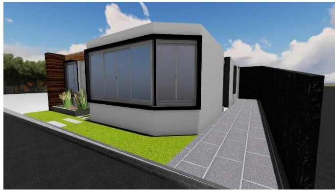
Figura Fachada lateral 3 Fuente: Propia
