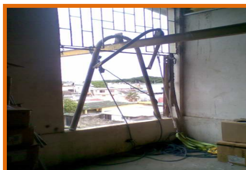
FIGURA 2.5. Ventana de izaje de materiales.
