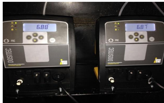
FIGURA 1.7 BOMBAS DOSIFICADORAS
