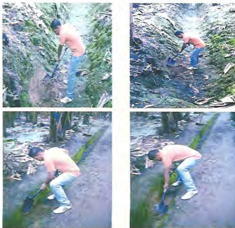
Figura 1: Limpieza de canales de drenaje
