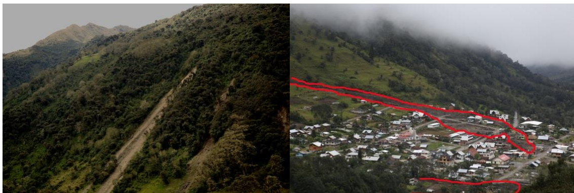
Figura 31: Derrumbes sector Nona, zonas escarpadas y coluvión de julio de 2015 (Fotografías del autor)
