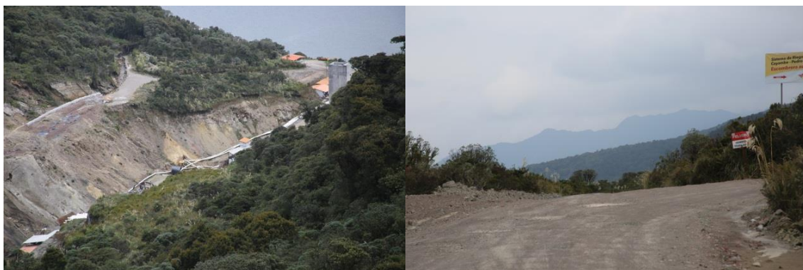
Figura 83: Laguna de San Marcos (Este de La Chimba, Proyecto de Riego San Marcos - Tabacundo), obras civiles con alto impacto en el bosque nativo y sistema de caminos abiertos para escombreras (Fotografías del autor)
