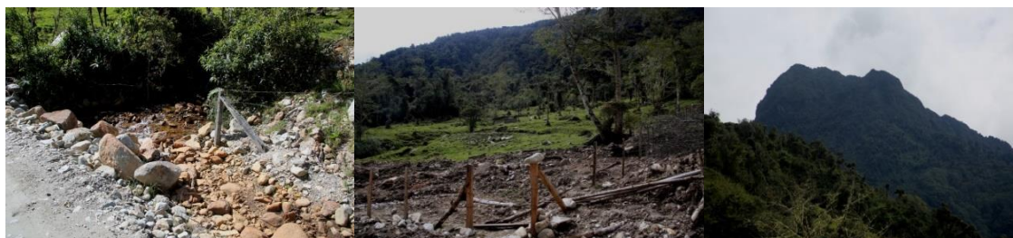
Figura 53: Pukalarca, derrumbe en Patucachi y Yanaurco (Fotografías del autor)
