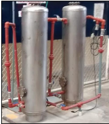
Figura 8. Filtros de Grava y de Carbón Activado
