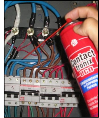
Figura 11. Colocación de Spray
