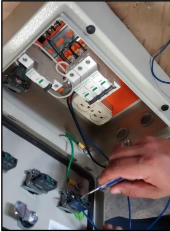
Figura 9. Ajuste de Pernos
