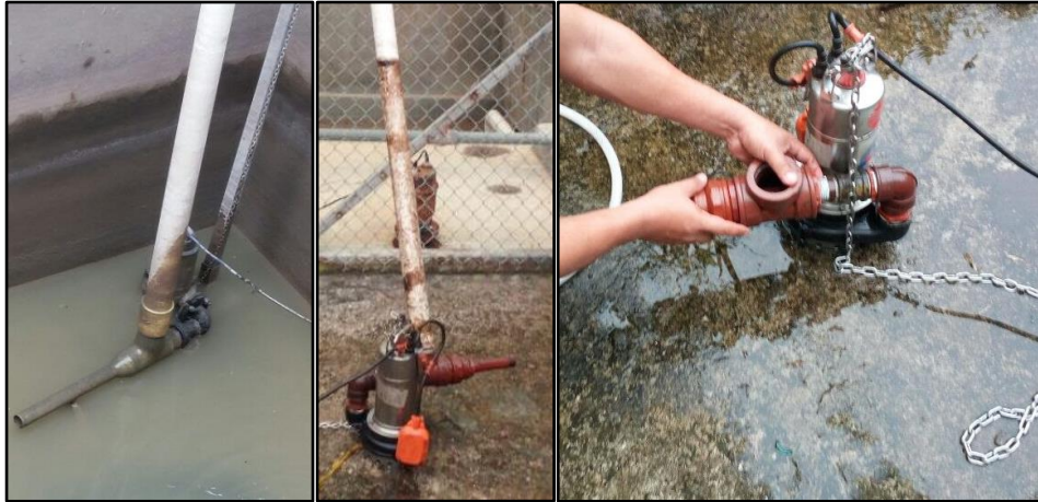
Figura 13. Limpieza de la Bomba de Aireación
