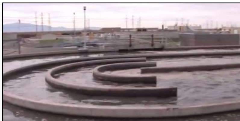
Figura 2.19. Desnitrificación por Canales de Oxidación
