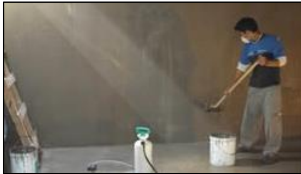
Figura 14. Reparación de Filtraciones en Reactor y/o Sedimentador
