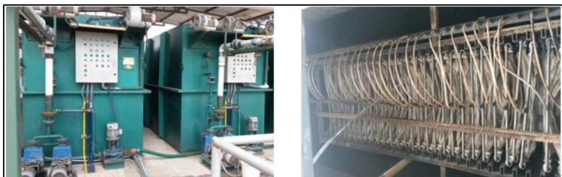
Figura 2.14. Filtración por Membranas de la PTAR ESPOL
