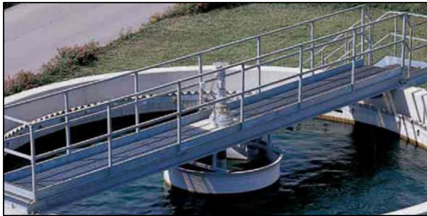
Figura 2.11. Sedimentador Circular
