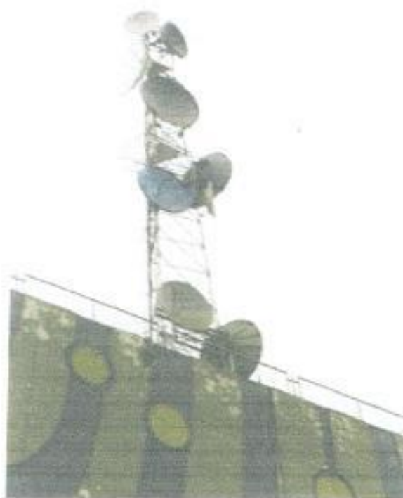
Figura 3.23 Central de Tránsito de Machala
