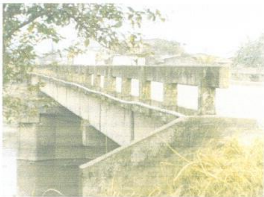
Figura 3.17 Sector 7: Puento Río Bulu Bulu
