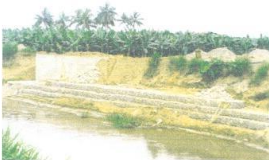
Figura 3.20 Diques de contención para canales de riego
