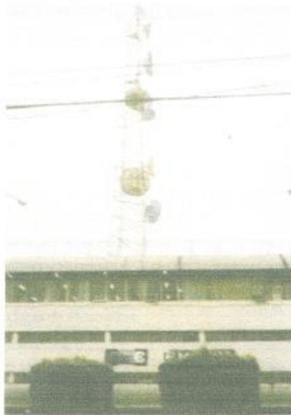
Figura 3.24 Central de Tránsito de Machala
