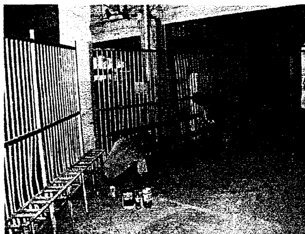
Figura 4.10 Pintado de estantes para bolsters o soportes
