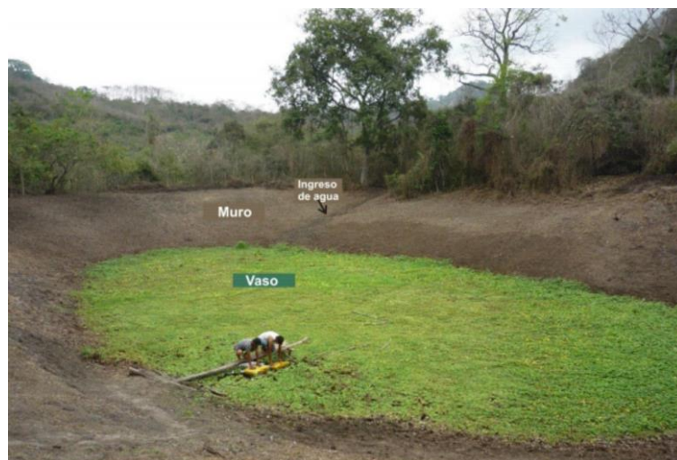
Figura 2. 6 Componentes principales de una albardada. (Albardada Las Coronas, Manabí) Fuente: Álvarez et, al., 2015.
