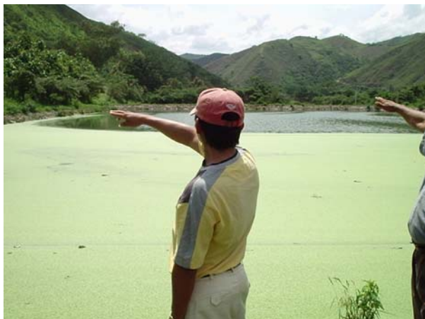
Foto N° 2: Laguna de Oxidación Cdla. La Florida Fuente: Municipio de Portovelo
