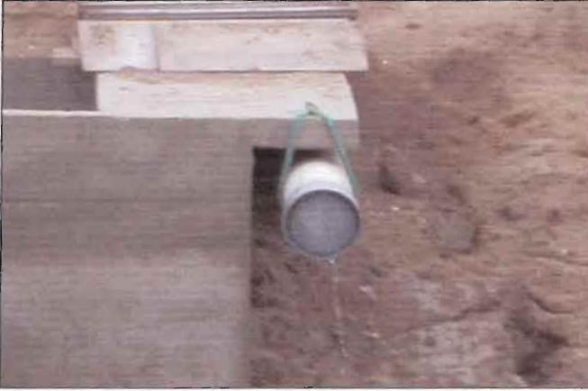
**Figura 16.-** Tubería de entrada de agua para las piscinas
