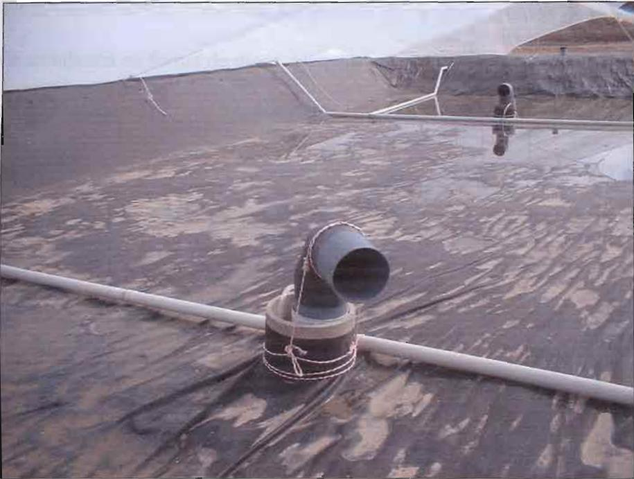
**Figura 21.-** Airlift instalado en una piscina provista con geomembrana (Foto: Autores).
