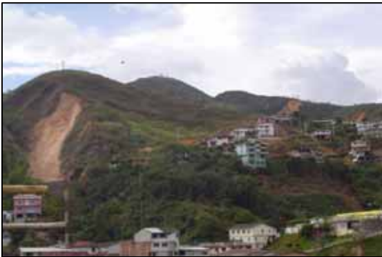
Foto 1. Deslizamiento en el Cerro el Calvario. Zaruma Fuente: Claudia Pesantes C.
