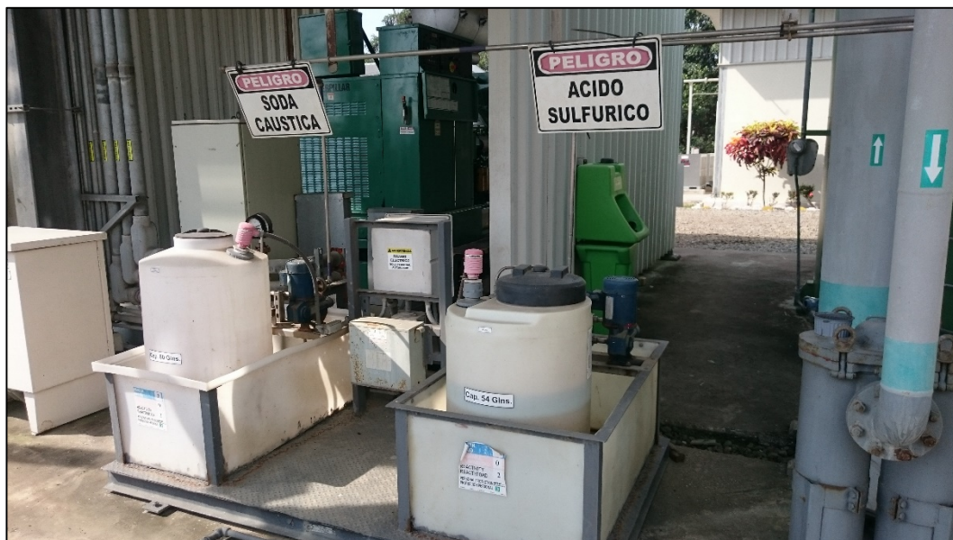
Figura 1.7 Sistema de Dosificación de Ácido y/o Base
