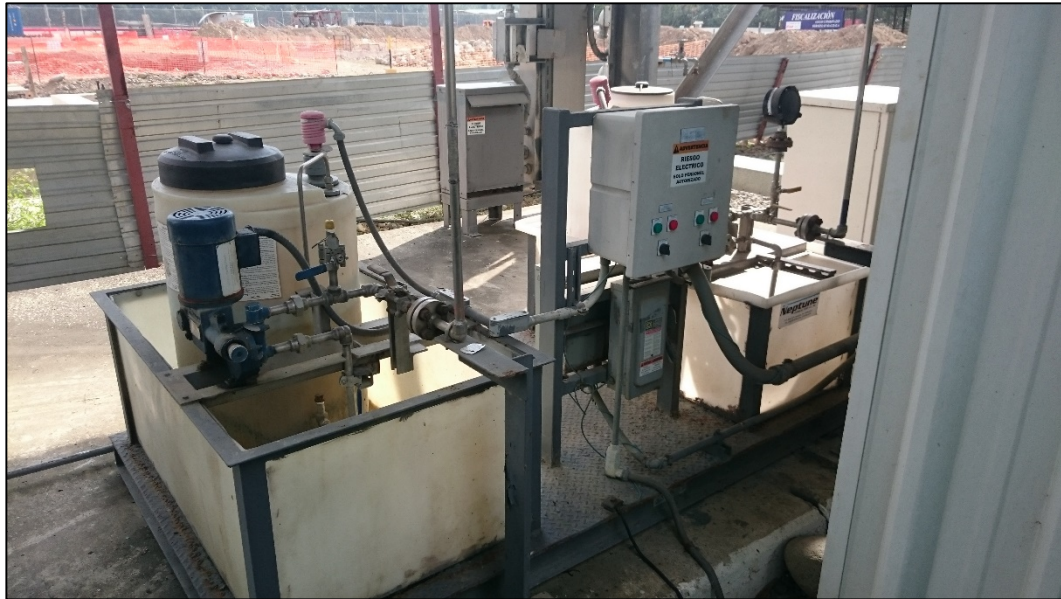
Figura 1.6 Sistema de Dosificación de Ácido y/o Base
