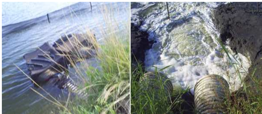
Figura #25: Tubería que comunica las piscinas adyacentes (vecinas)
