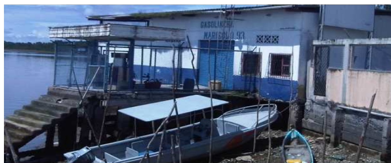
Figura #15: Estación de abastecimiento de combustible para embarcaciones pesqueras.
