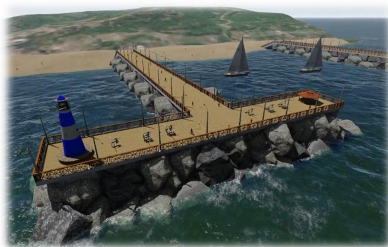
Figura 2.20 Implementación de los espigones en T en la zona de estudio [Autores, 2020].
