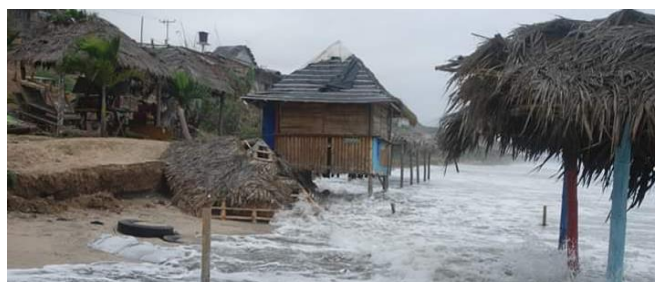
Figura 1.3 Comuna Libertador Bolívar afectada por erosión (Caiza & Nativi, 2019).
