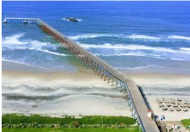
Figura 3.22 Muelle de concreto en playa de Rosarito. Fuente: (Yelp, 2020)
