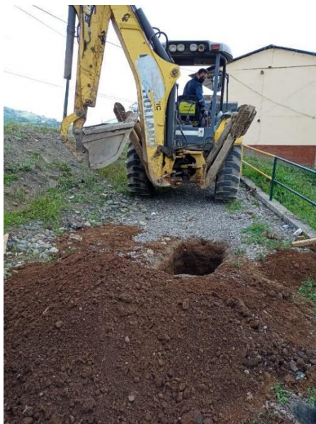
Figura 2.8 Excavación de calicata 5 [Córdova & Choez, 2021]
