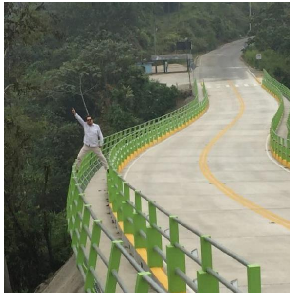
Figura 1.9 Tramo de paso Pinhuapungo con solución geotécnica aplicada [Chávez, M., 2016]
