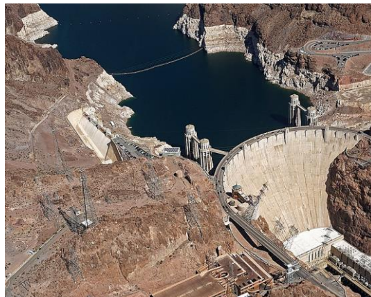
Figura 1.6 Presa de hormigón en forma de arco Hoover Dam, Nevada-Arizona [Bureau of reclamation, 2017]
