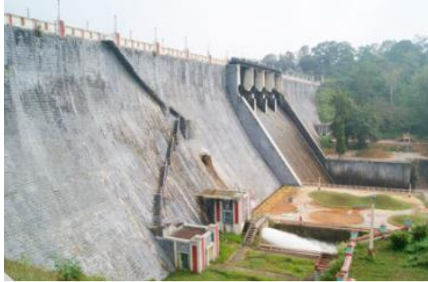
Figura 1.7 Presa de gravedad Neyyar dam, Kerala-India del sur [Alamy, 2010]
