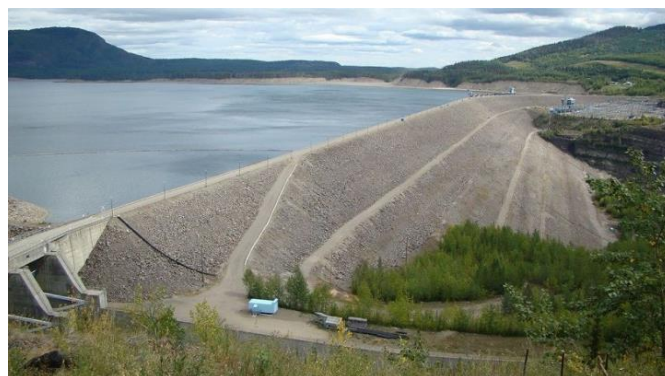
Figura 1.8 Presa de materiales sueltos W.A.C, España [Structuralia, 2018]
