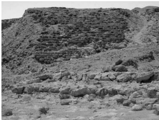
Figura 1.13 Vista general del paramento aguas arriba de la presa Kaffara [Castillo J., Cervelló J., et al., 2007]
