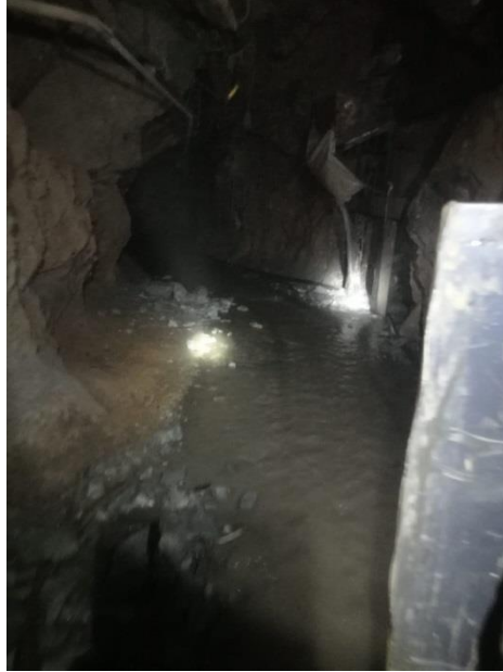
Figura 6.8 Presencia de curvas pronunciadas
