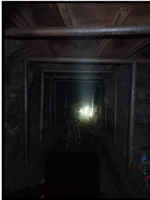
Figura 2.12 Sostenimiento del frente de avance.
