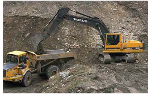
Figura 8. Carga de material en volqueta.
